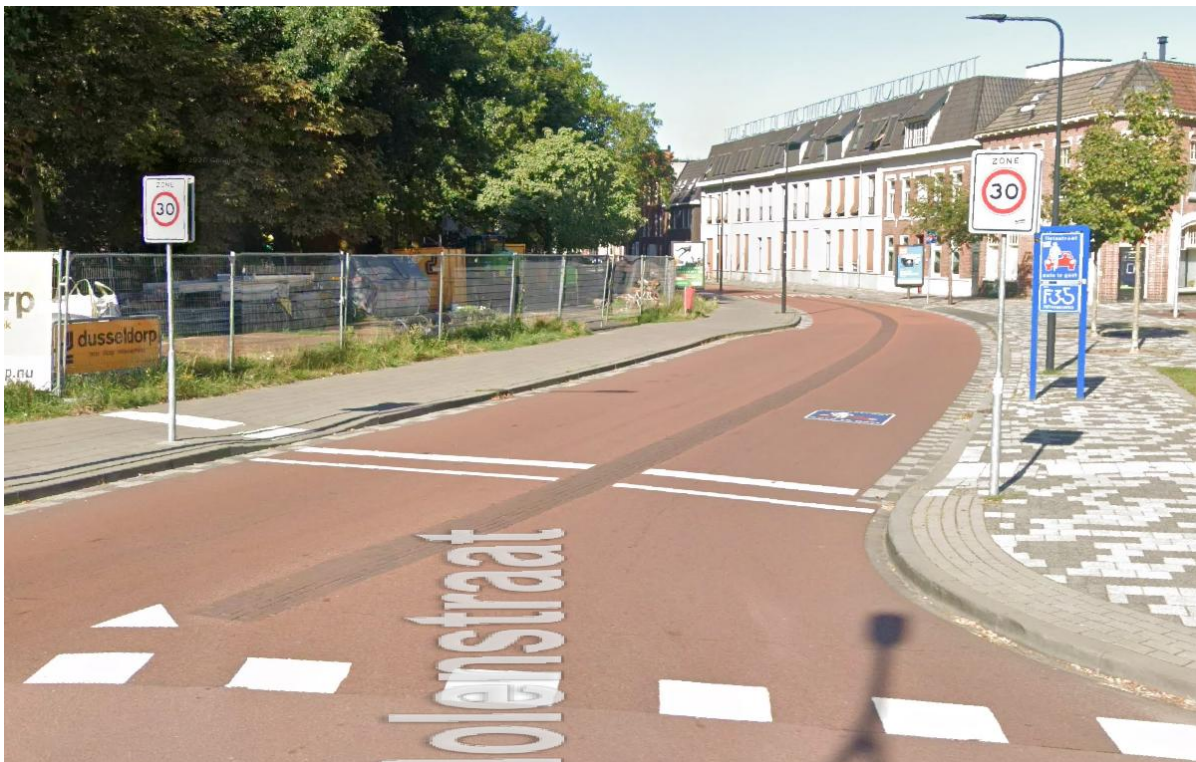
Afbeelding 6: Voorbeeld poortconstructie fietsstraat (Oldenzaalsestraat, Enschede)
