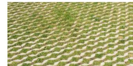
Grasbetontegels als waterpasserende bestrating
