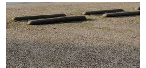
Betonnen stootbanden bij parkeren in halfverharding
