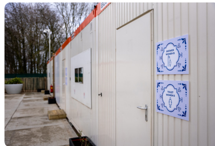
Figuur 19: Sanitair in een container, waar kinderen door de buitenlucht naar toe moeten om naar het toilet te gaan of te douchen (bron: verkregen van de uitvoerende organisatie van deze noodopvanglocatie (TGO)).
