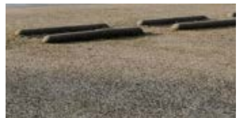
Betonnen stootbanden bij parkeren in halfverharding
