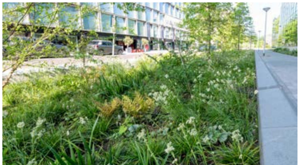
Referentie: verdiepte plantvakken zorgen voor waterinfiltratie
