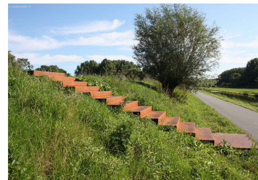
Referentie: Extra trap vanaf talud fietsbrug zorgt voor wandelverbinding om de kleiputten heen.
