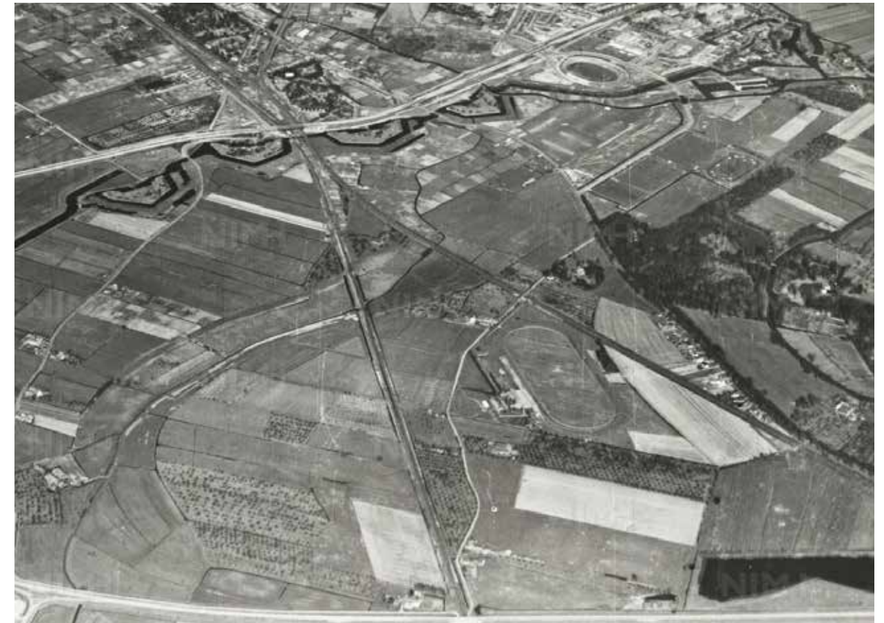
Luchtfoto van De Vier Lunetten als onderdeel van de Nieuwe Hollandse Waterlinie, omstreeks 1945
