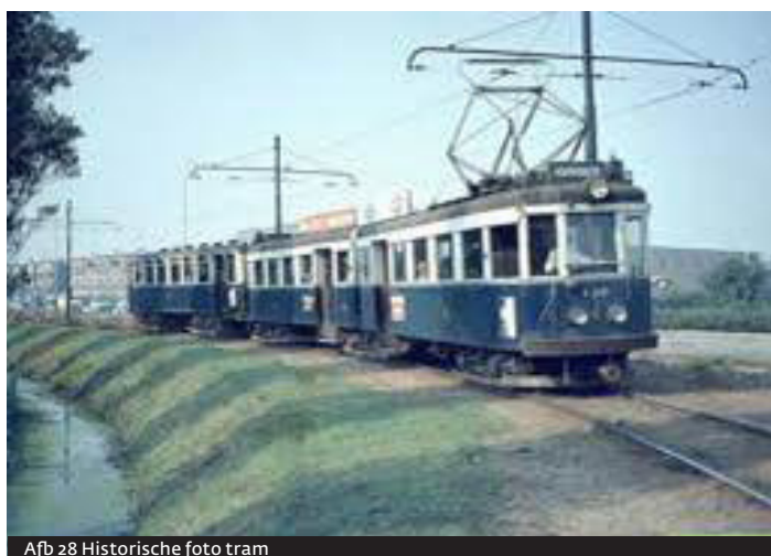
Afb 28 Historische foto tram
