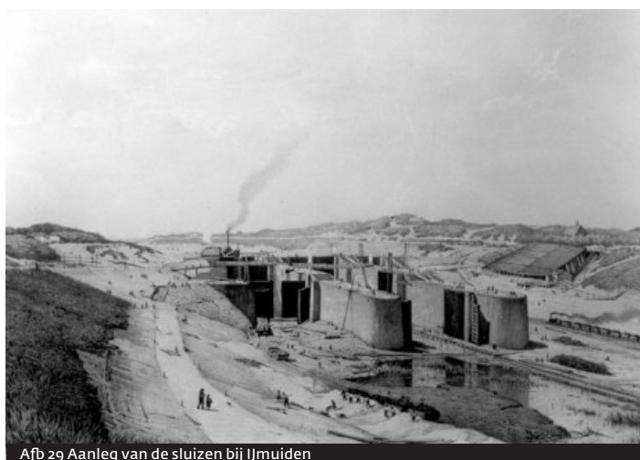
Afb 29 Aanleg van de sluizen bij IJmuiden
