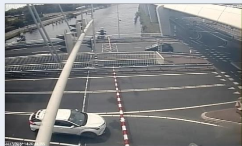
PT2 preset brug
