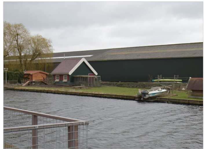
het perceel van Houthandel Sneek achter het perceel van de noordelijke buren gezien - een bijzonder landschap?
