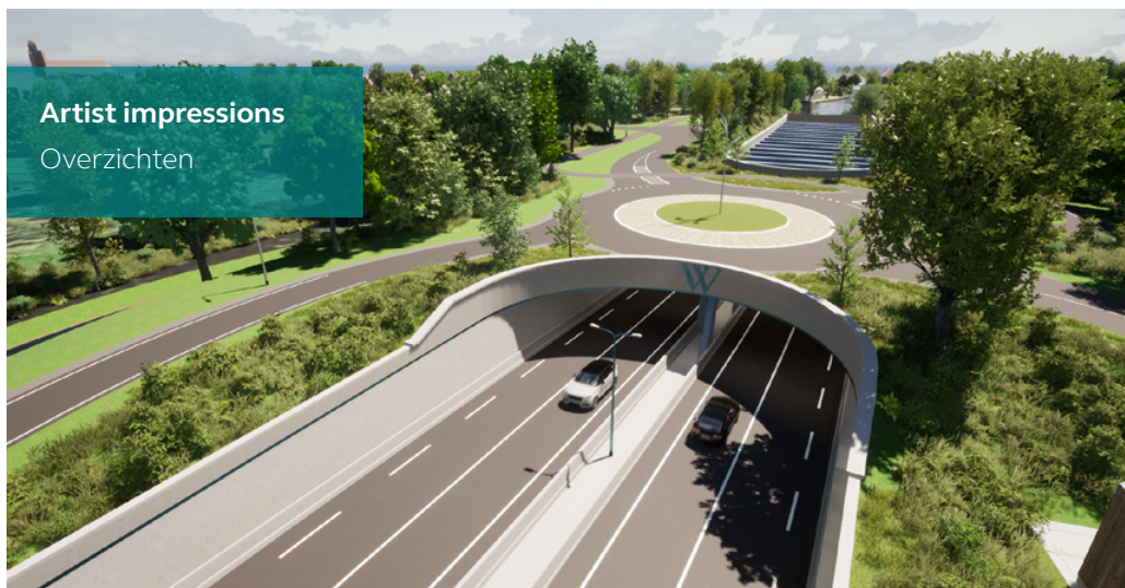
Overzicht westelijke toegang onderdoorgang
