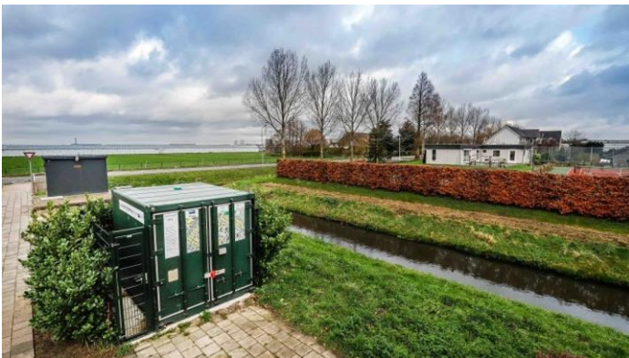
Afbeelding IV.4 Rijsenhout buurtbatterij - 128 kWh
