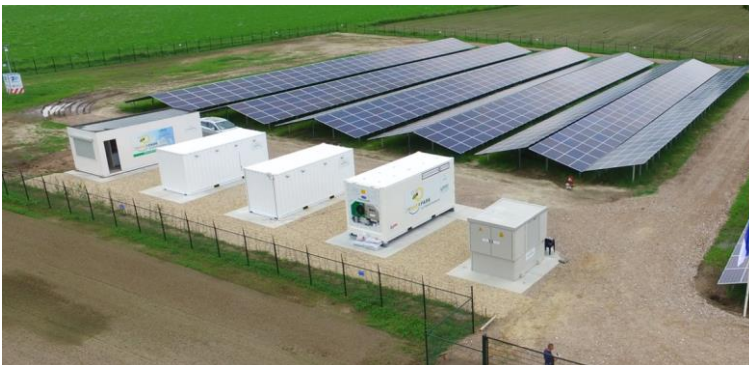
Afbeelding IV.5 Altweeterheide zonnepark batterij - 617 kWh
