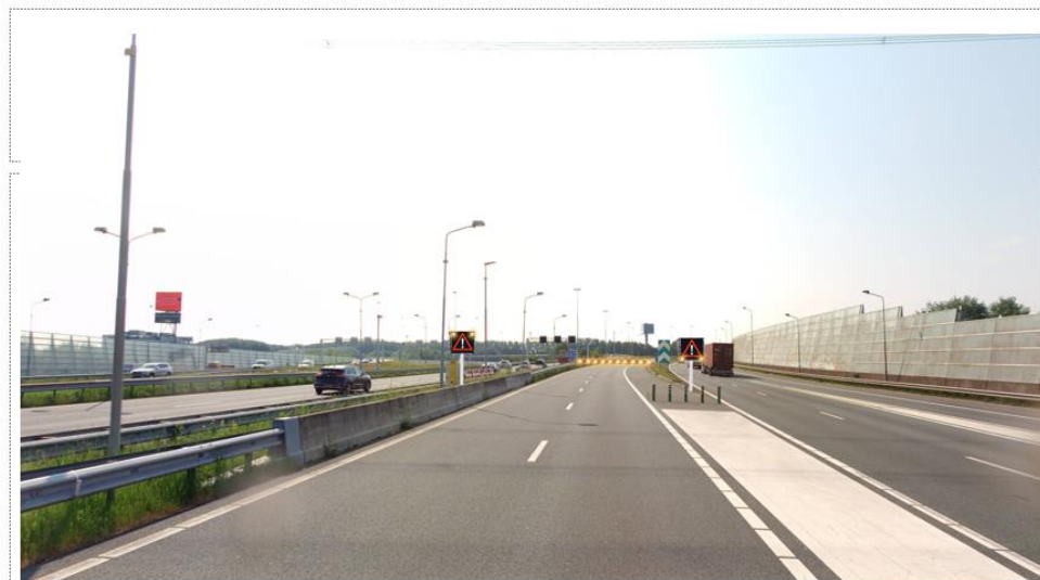
Figuur 5.12: Verplaatsing slagboom/barrier
