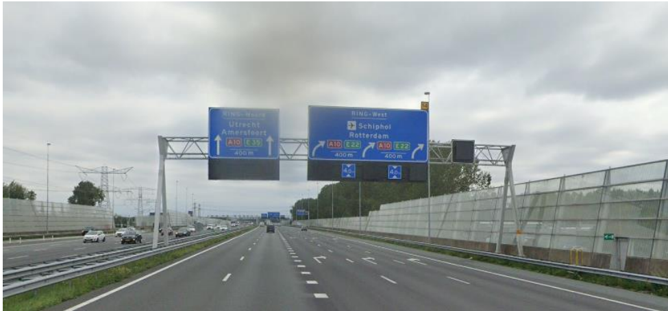
Figuur 5.14: Bestaande situatie
