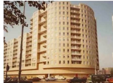
Woningbouw aan de oostzijde: De Pompenburgflat 1982 ontworpen door Carel Weeber
