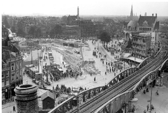
Werkzaamheden aan het Hofplein, 9 maanden voor het bombardement (ANP)
