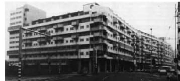
Woningbouw aan de westzijde: Het Weenahof 1982, ontworpen door Passchier Vandensteen
