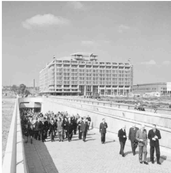
Opening Weenatunnel 1952. Op de achtergrond het Groot Handelsgebouw. (Cultuurhistorische verkenning Weena Hofplein 2017)
