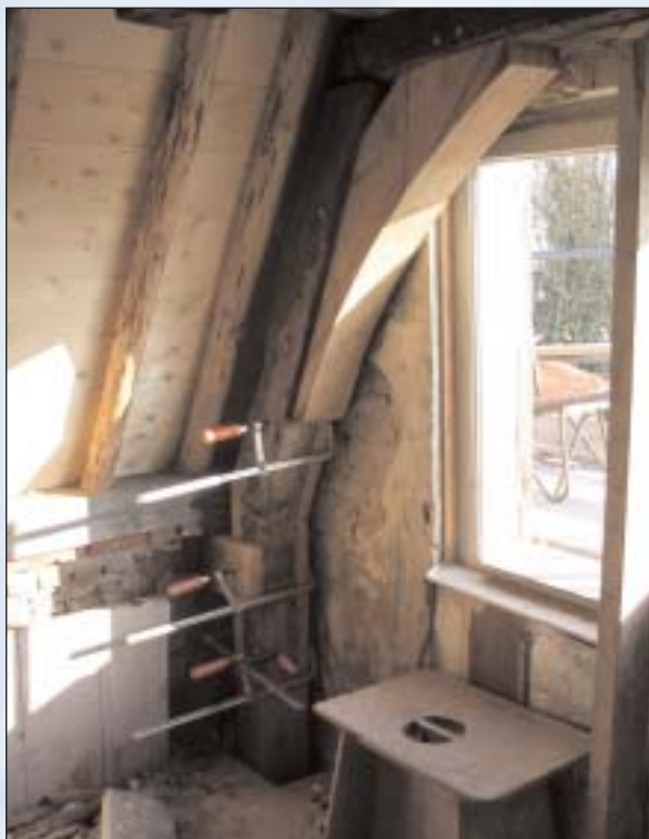
Restauratie spantbeen in het monumentale pand Oosthaven 18
