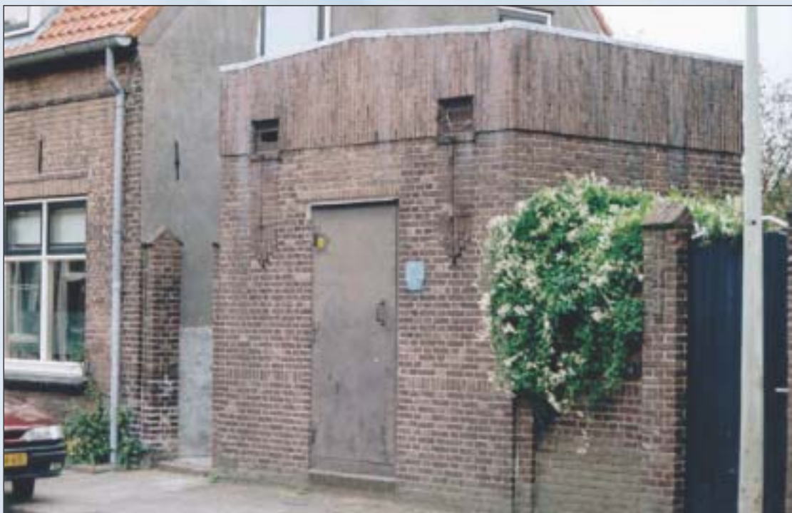
Transformatorhuisje aan de Sint Josephstraat 49-51 in het tuindorp de Josephbuurt.
