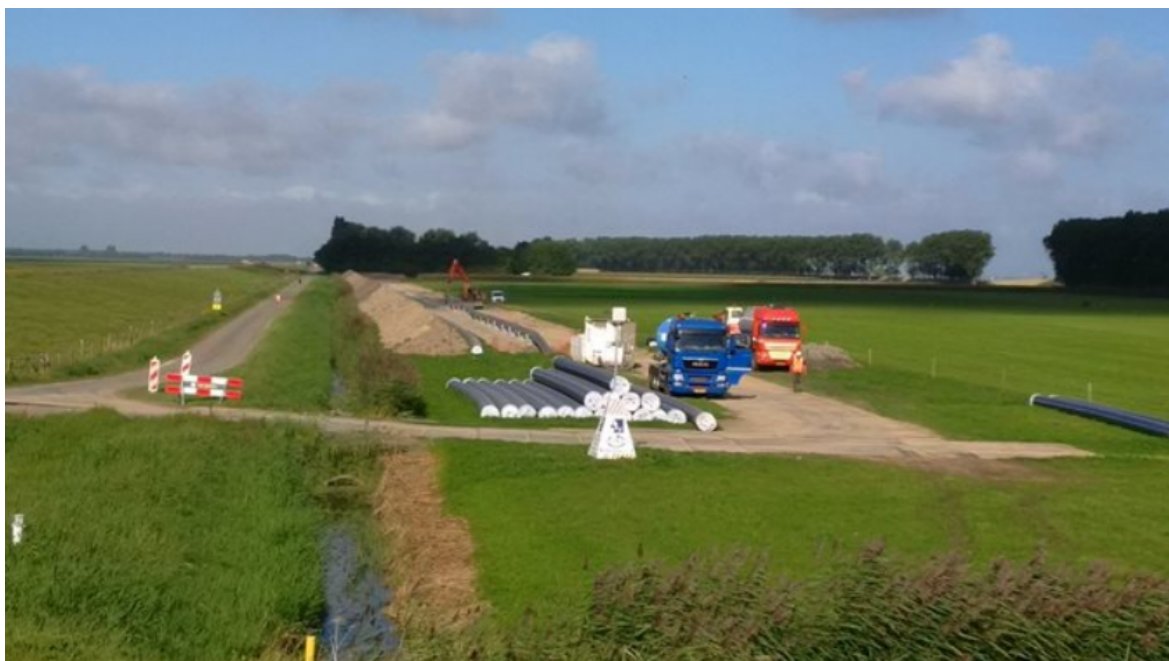
Figuur 8: Aanleg Evides infiltratieleiding nabij de sifons van Middelharnis (bron: www.evides.nl )
