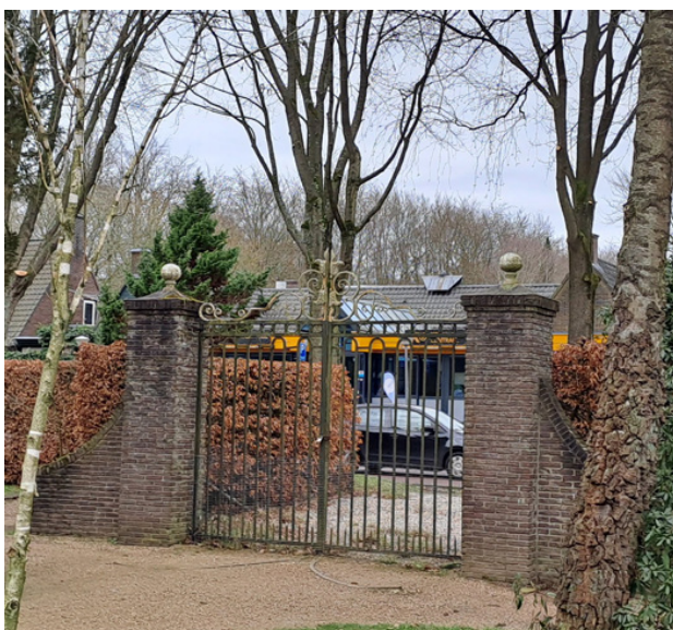
In een onbekende bouwphase (XXd) naar de Kwartelweg verplaatste negentiende-eeuwse ijzeren entreehek tussen opnieuw opgemestelde pijlers met herplaatste pironnen.
