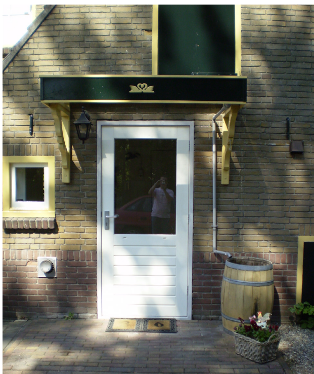
Foto uit 2024 van achtergevel. Goed zichtbaar zijn de recentelijk aangebrachte glasdeur en luifel daarboven. Het kleine raampje links bevindt zich ter plaatse van het oorspronkelijke toilet, dat in een secundaire bouwphase is weggebroken.
