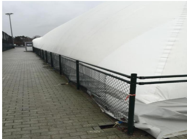
Verankering middels Stelconplaten, betonblokken en spanbanden aan de 4 e zijde van het veld:
