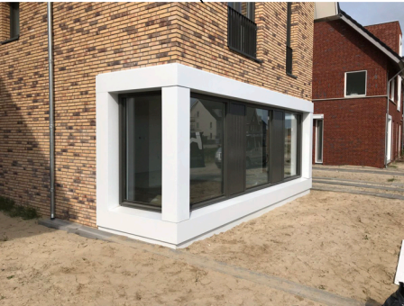
Vrijdragend geïsoleerd gevelement, aluminium, wit RAL 9010, Meilof Riks o.g.w.
