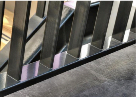
Stripstalen balustrade, verzinkt, 3laags poedercoating RAL 9004, mat, korrelstructuur
