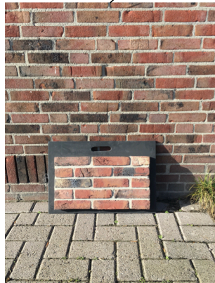
Metselwerk, bijpassend als bestaand, voegen max. 8mm, kleur en type ntb
