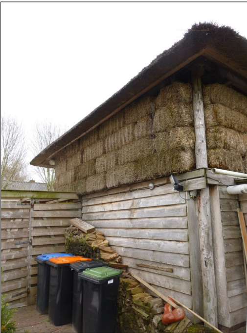
Afbeelding 3: De schuur (met het uiterlijk van een hooischuur) met de rieten dakbedekking en de stobalen afwerking van de buitenzijde van de zolder. Foto: K. de Vries | Ecoresult B.V.
