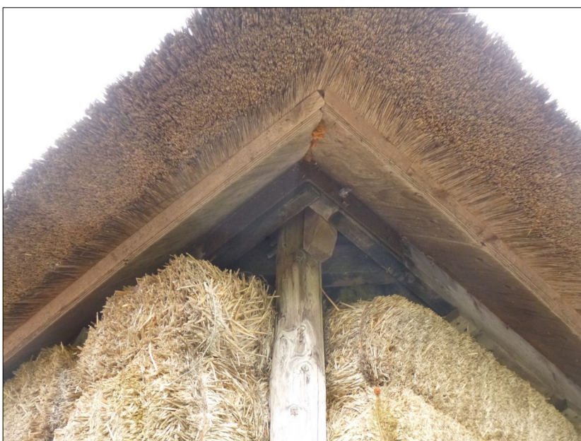
Tussen de onderzijde van het dak van de schuur en de stobalen is ruimte aanwezig. Foto: K. de Vries | Ecoresult B.V.
