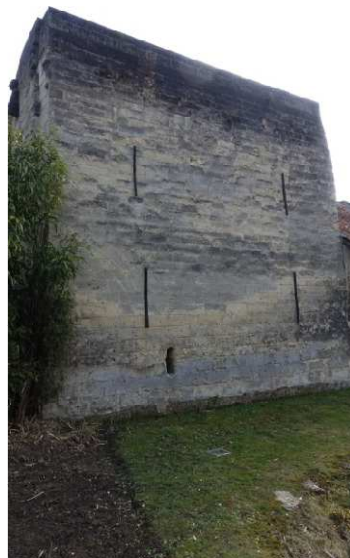
Figuur 4. Aan de onderzijde van de muur van het schuurtje (links) en de vierkante toren (rechts) bevinden zich respectievelijk drie en één spleetvormige openingen. In de zijkant van het schuurtje bevinden zich nog twee ronde openingen.
