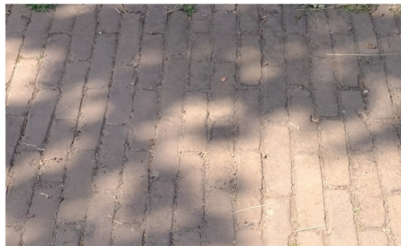
Hergebruik bestaande straatbaksteen
