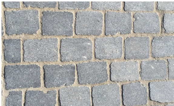
De bestaande kasseien expeditieplein worden opgepakt en gezaagd
