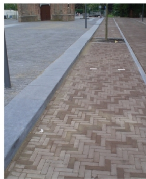
Opsluitbanden en trottoirband in hardsteen
