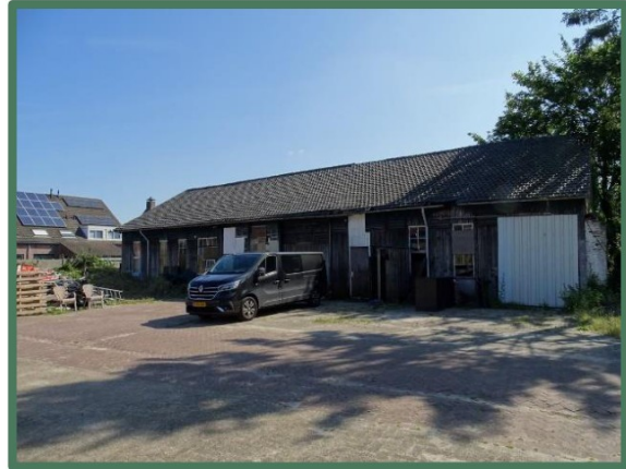
Overzicht oostelijke schuur vanuit westen
