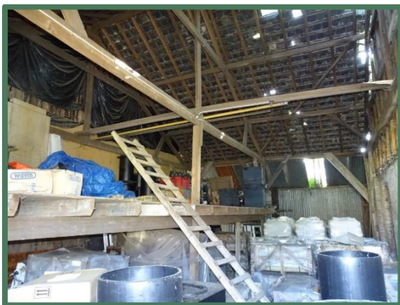
Binnenzijde oostelijke loods
