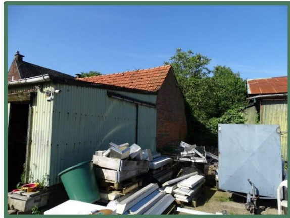
Overzicht oude schuur vanuit noordoosten
