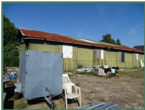
Overzicht westelijke loods vanuit oosten
