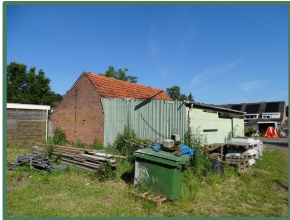
Overzicht oude schuur vanuit zuidoosten
