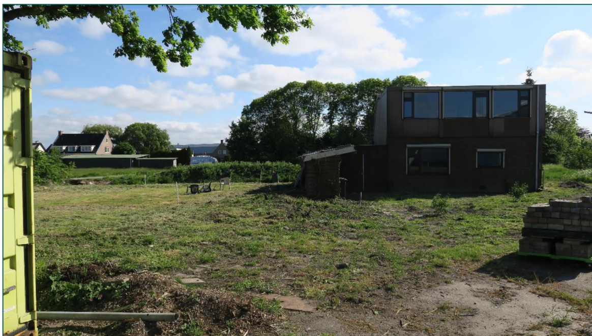
Figuur 1 De planlocatie is gelegen aan de Molenweg 59 te Berkel en Rodenrijs en bestaat uit een voormalig woonperceel met woning, aanbouw en onderhouden tuin. De beoogde ruimtelijke ingreep betreft de sloop van de bebouwing ten behoeve van een nieuwbouwwoning.
