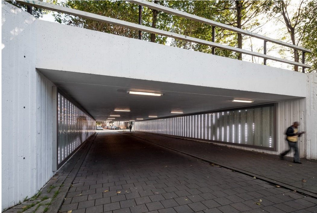
Amsterdam Ben Viljoenstraat Rechte tunnel met maximaal doorzicht, extra breed profiel, hoogwaardige afwerking met kunst en goede verlichting 38 m lang, 8 m breed
