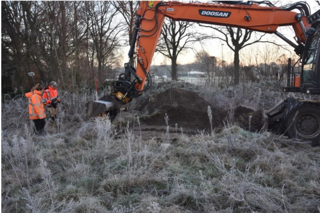
Fig. 1.4. Aalst-Brabantia. Werkzaamheden bij de aanleg van proefsleuf 1.
