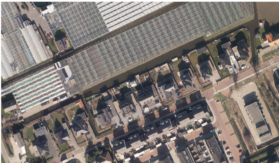
De watergang gelegen achter de woningen Boerenlaan 2 tot en met 8D
