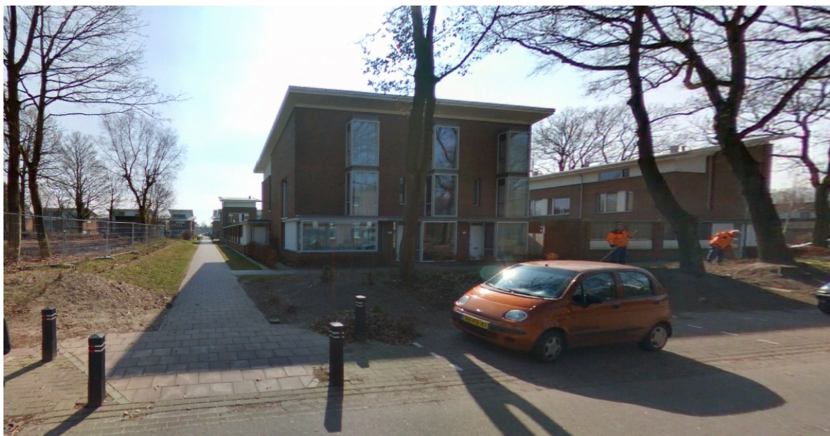
Figuur 5.10: reeds gerealiseerde woningen en verbindingspad
