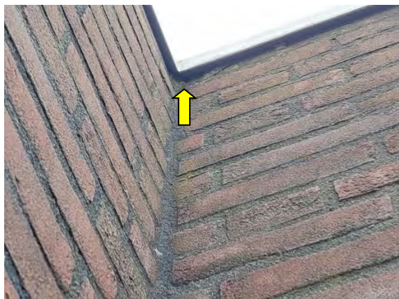
Figuur 5.2 Ruimte onder daklijst.
