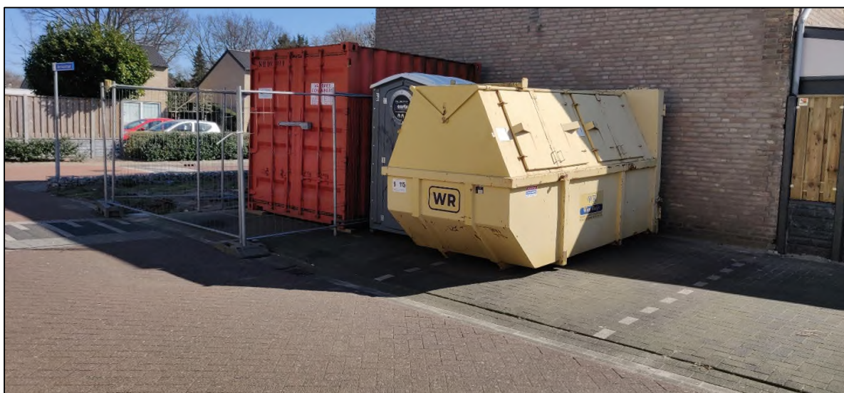
Figuur 6 Bouwmaterialen ten behoeve van drie openbare parkeerplaatsen in Berliozstraat (Deelgebied D)
