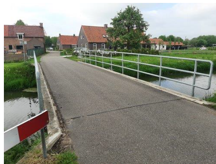
Vernieuwd brugdek en gegalvaniseerde leuningen
