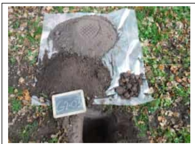
Foto: Inspectiegat G2-03
