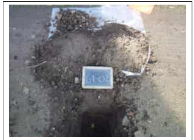
Foto: Inspectiegat G1-02
