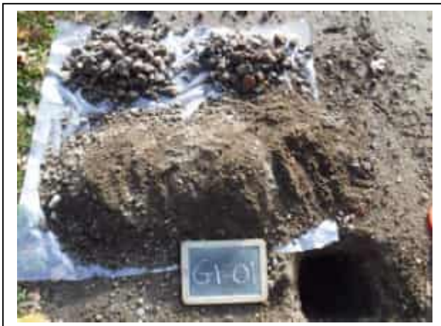
Foto: Inspectiegat G1-01
