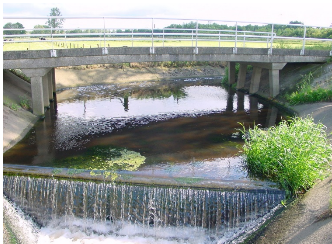
Figuur 1-1: Afvoer water vanuit Losser naar de Dinkel.
