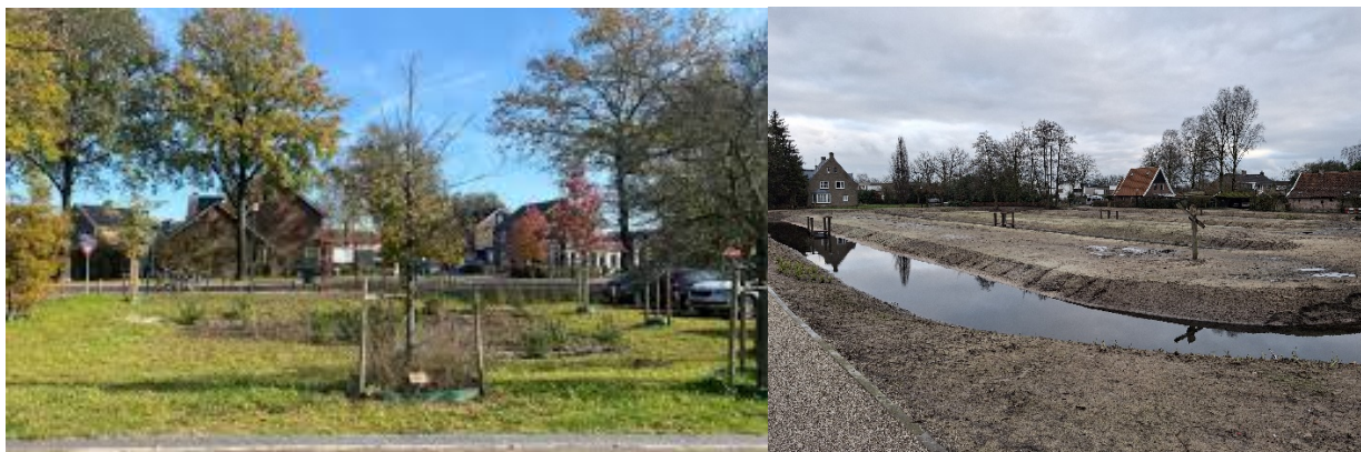
Figuur 3-1: Wadi De Lutte Centrumplein (links) en herstel De Bleek (rechts).
