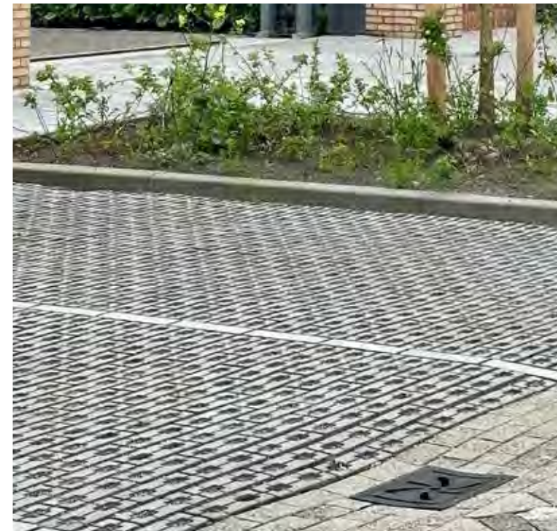
waterdoorlatende bestrating parkeerplaatsen
