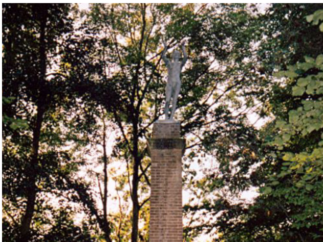
DE GEMETSELDE ZUIL MET HET GIETZINKEN BEELD VOOR DE RESTAURATIE. 2000
