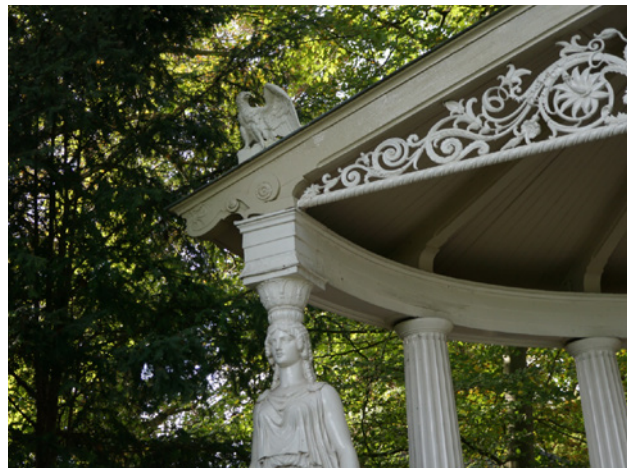
DETAIL VAN DE GIETZINKEN KARYATIDEN, KOLOMMEN, SPANT EN ADELAAR.
