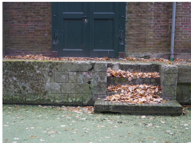
ZICHT OP DE ALS RUSTIEKE BLOKKEN VORMGEGEVEN KADEMUUR.
