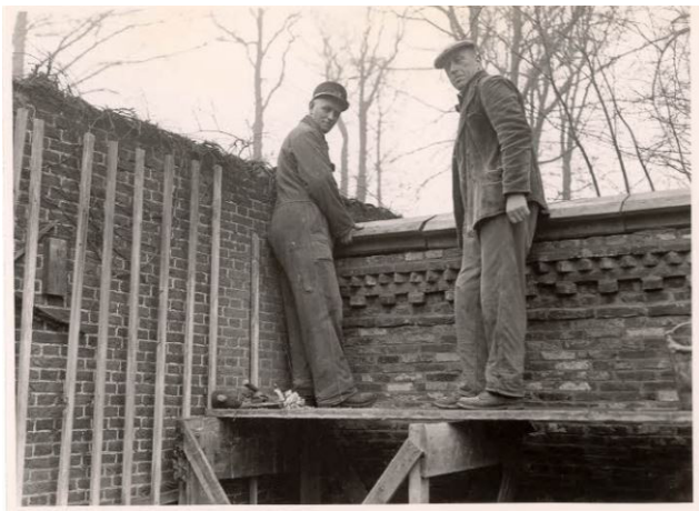
DE TUINMUUR TIJDENS DE BOUW IN 1950
