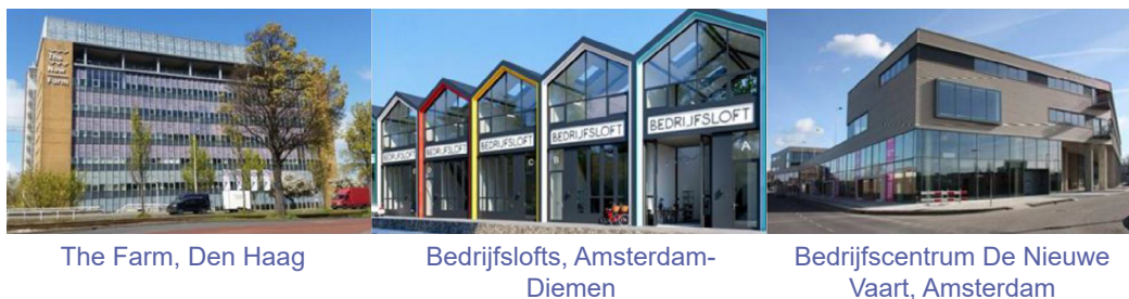
Figuur 25: Voorbeelden van meerlaagse bedrijfsruimten
