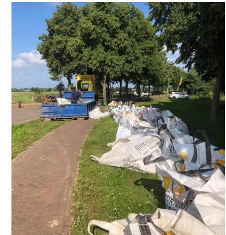
De aanleg van de nooddijk in Leudal. Bron: dhr. R. Martens
