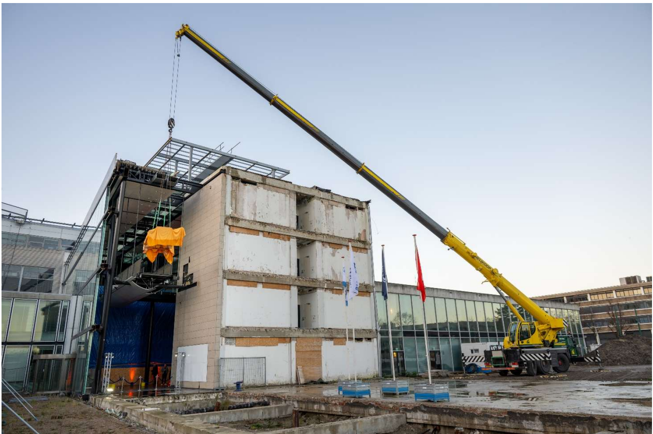
Figuur 5: Project At The Park, Kessler Park e.o - start van sloop-nieuwbouw
