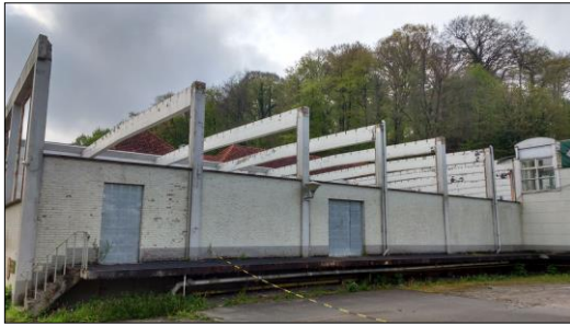
De te slopen bebouwing en spanten van de voormalige brouwerij.
