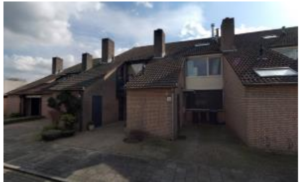
Aangebouwd bijgebouw in het verlengde van het dakvlak (Efferen)
