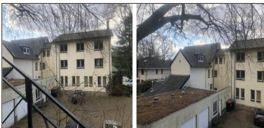
Figuur 6. Aanzicht plangebied achterzijde vanuit het achterterrein (bron: CB5)
