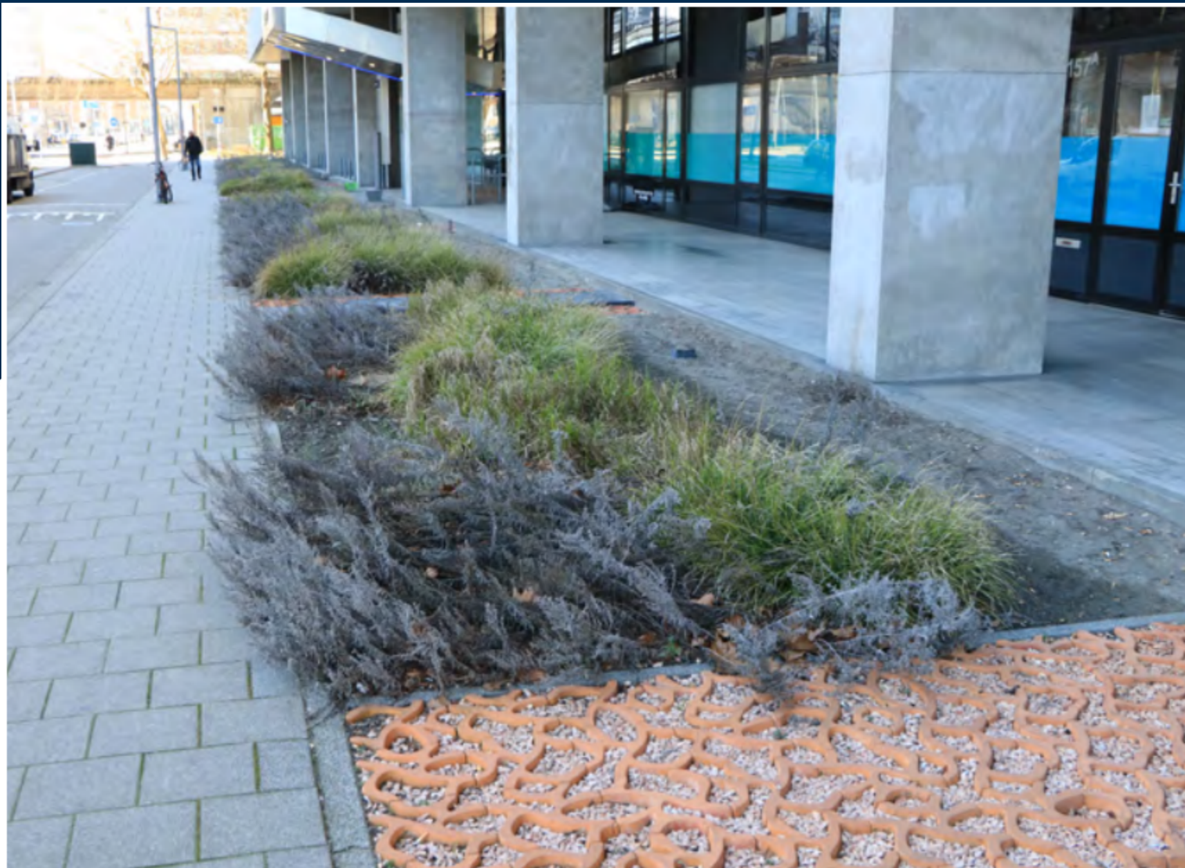
Toepassing van Rain(a)way Flood tegels in een groenstrook
