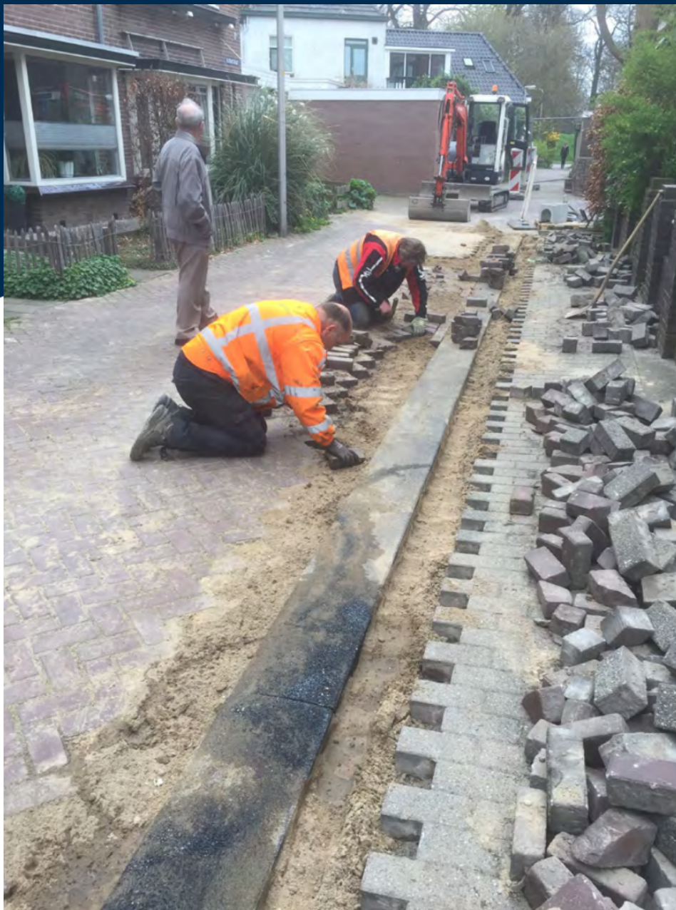
Aanleg van een infiltratievoorziening van Permeoblokken
