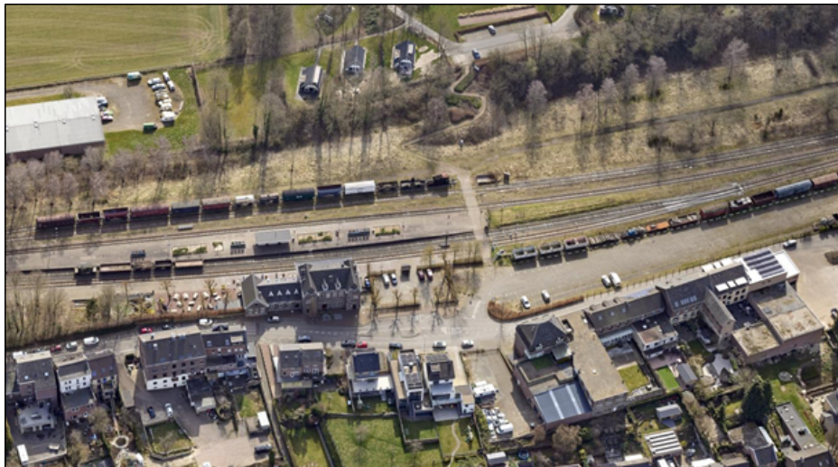
Foto's bestaande situatie spoorpark emplacement
