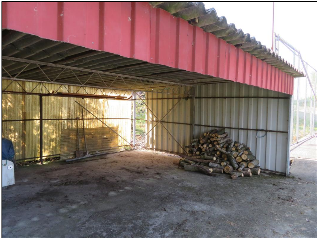
Figuur 4 Op het sportveld staat een open schuur van damwandplaten.
