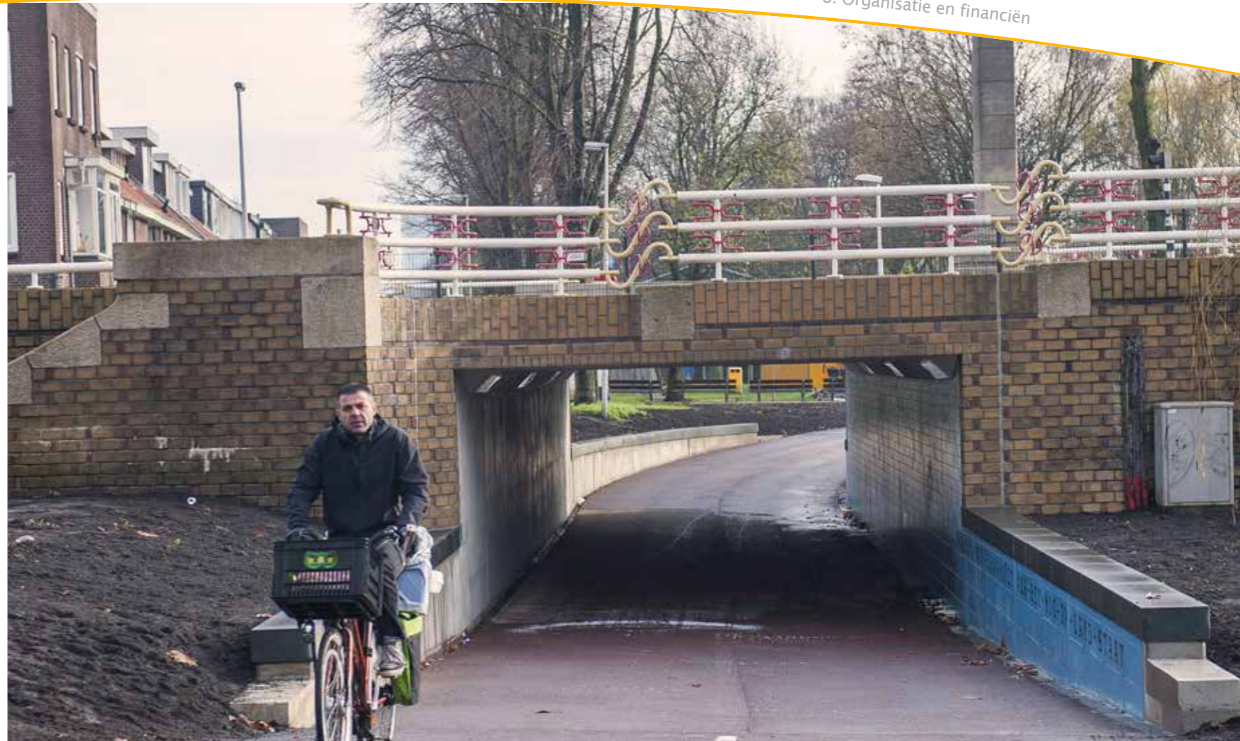
Eind 2014 is de fietsonderdoorgang bij de Spinozabrug geopend, waardoor verschillende routes tussen noord- en zuid-Utrecht directer en dus sneller zijn geworden.
