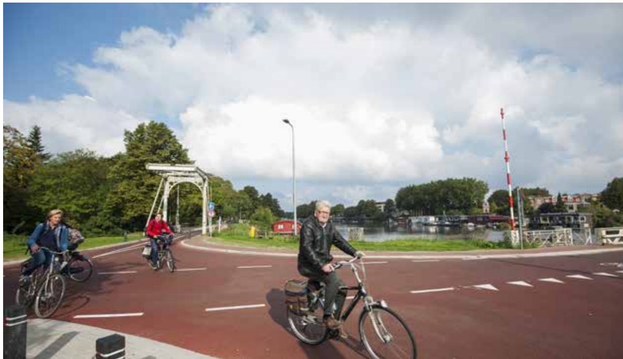
Ook op deze hoofdfietsroute (hier kruispunt Leidseweg - Kanaalweg) is rood asfalt aangebracht.
