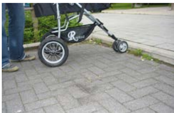
Kleine hoogverschillen vormen al een belemmering
