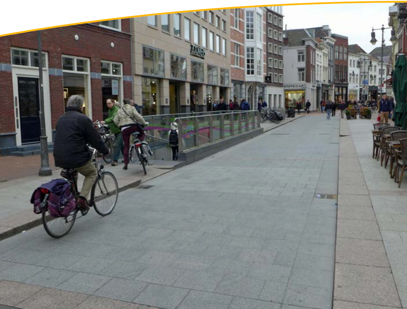
De overgang naar het trottoir is schuin gemaakt
