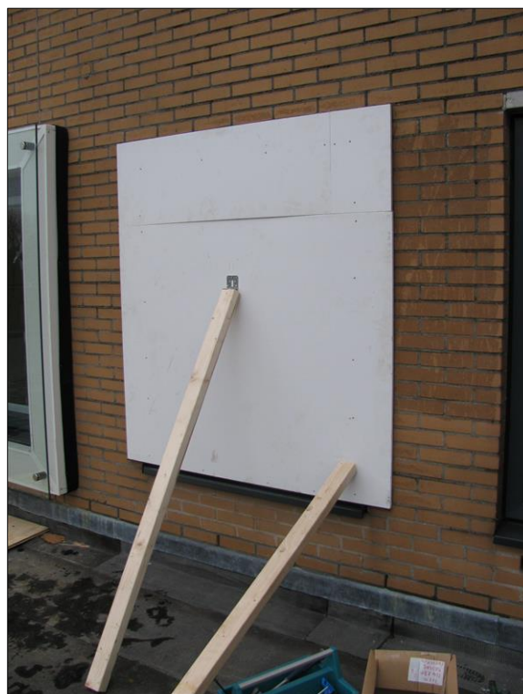
Foto II.4 Provisorische afdichting tweede raam
