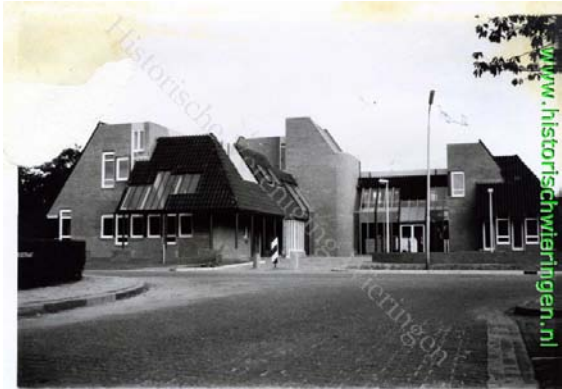
afb.19 situatie begin jaren '80 raadhuis Wieringen
