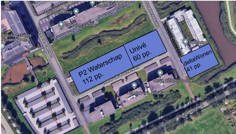
De drie parkeerterreinen die onderdeel zijn van de pilot slim parkeren
