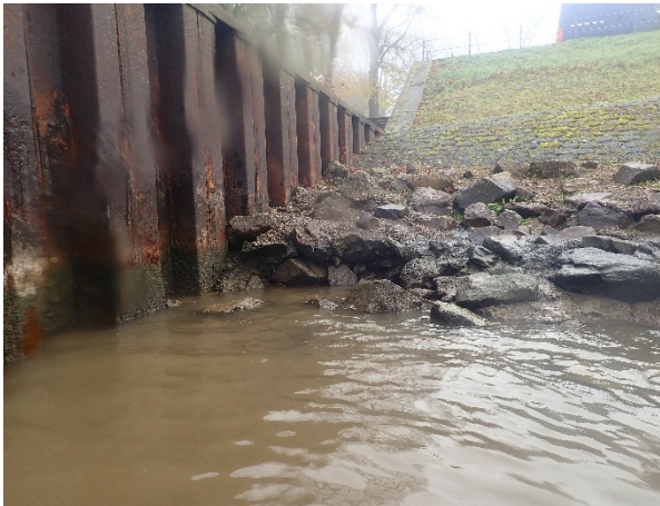
Figuur 6.7: Aansluitende oeverbescherming.
