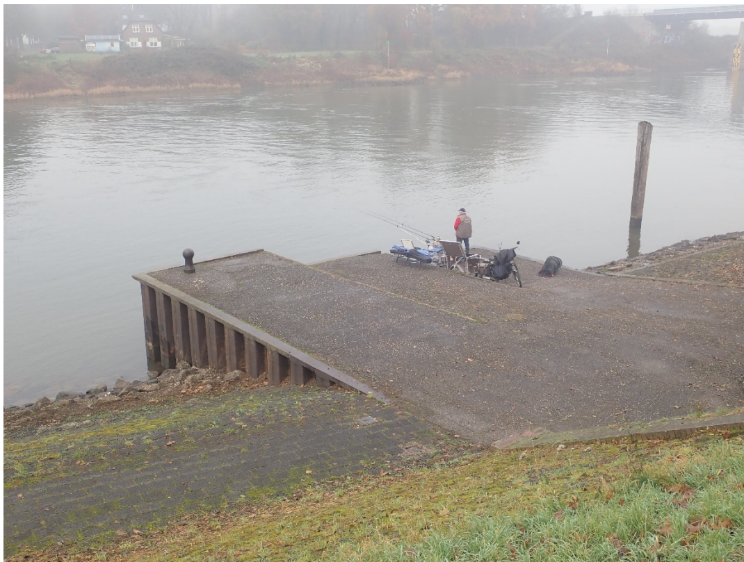
Figuur 1.1: Overzicht aanlegsteiger Doesburg.
