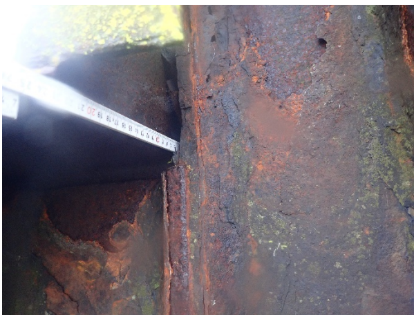
Figuur 6.5: Gaten damwand met aansluiting deksloof.
