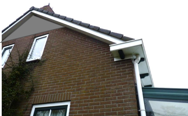
Figuur 26 De westgevel van het woonhuis Achteromweg 3 met een aanduiding voor de locatie van de betimmering (grijs vlak)
